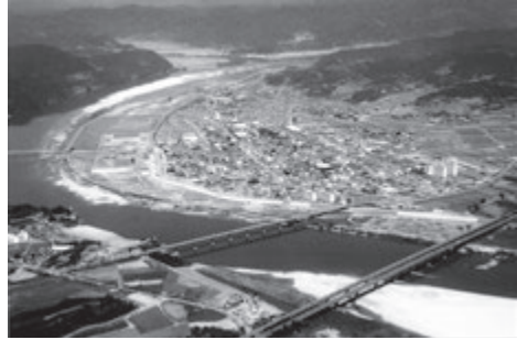
남지 제방축조 (후) / 사진 : 하동철
